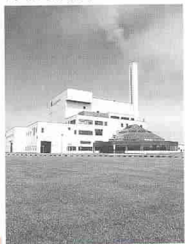
▼クリンクルセンター
