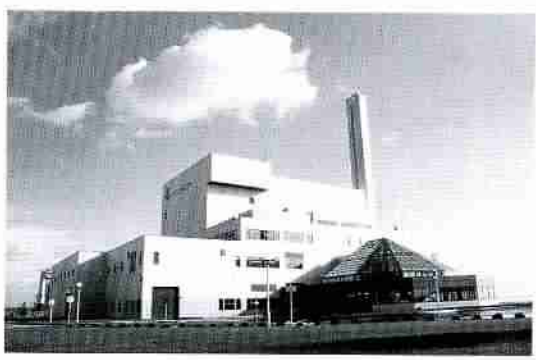
▲優れた焼却処理能力をもつ「クリンクルセンター」
