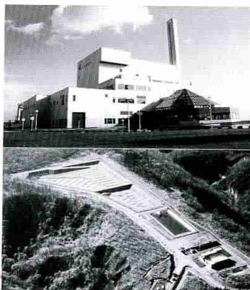
◀クリンクルセンター
