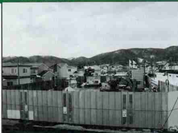
◀建設中の若草ポンプ場
