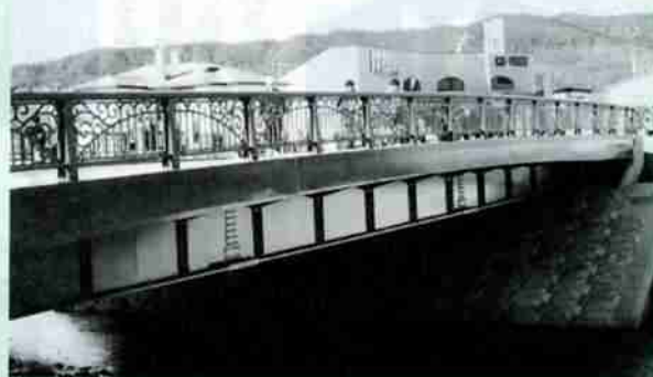
▲完成した新しい富士橋
