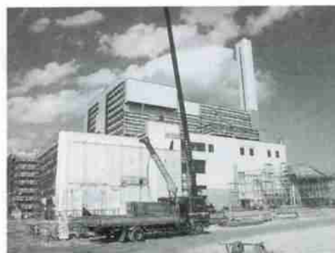
▲幸町に建設中の「クリンクルセンター」処理施設
