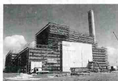
▲建設中の新ごみ処理施設「クリンクルセンター」
