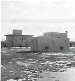
▲若山浄化センター
