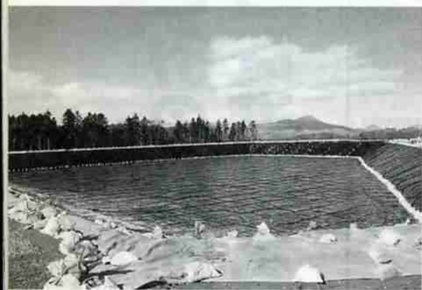
▲建設中の新しい「最終処分場」
