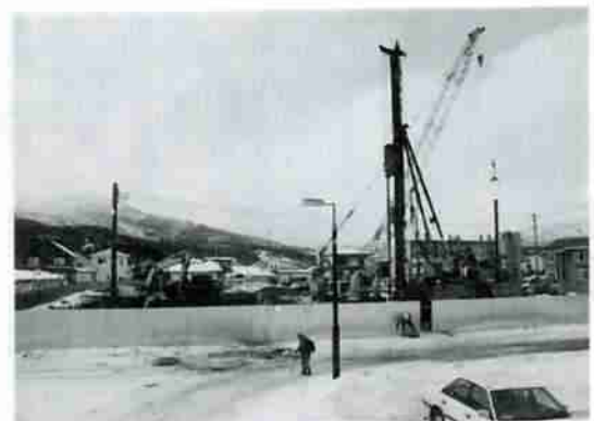
▲建設中の市営桜木団地
