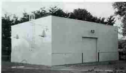
▲災害緊急用資材保管庫 (幌別浄水場横)
