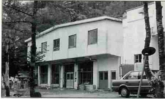
▲高区配水池建設事業を行う登別温泉浄水場
