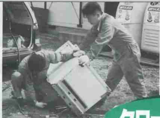
▼冷蔵庫のフロンガス抜き取り
