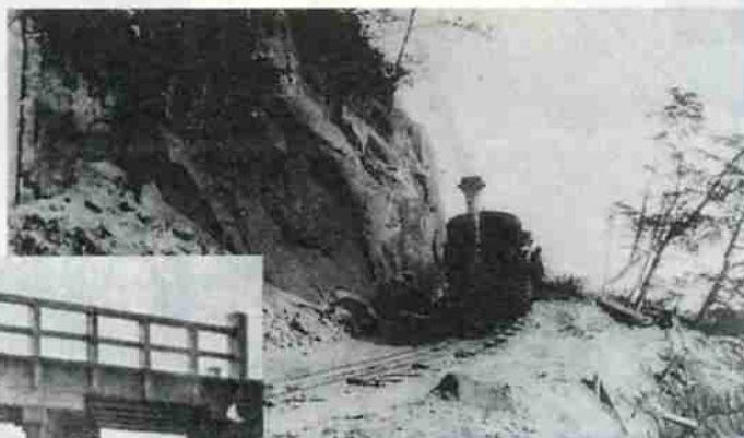
▲紅葉谷付近を煙を出して走る蒸気機関車。 (1918年8月～1925年11月) 周囲はまだ、岩の崩落もあり、開削工事の 難事業がうかがえる。
