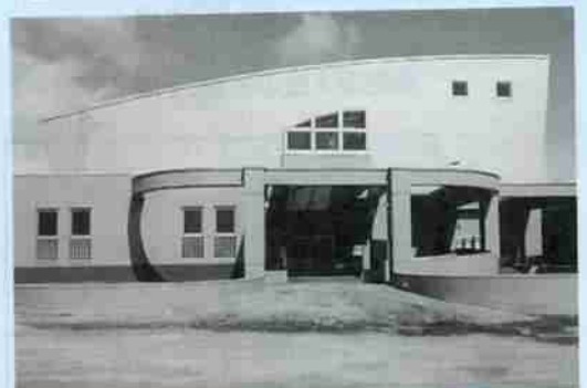
▲暖房などが整備された幌別中学校屋内運動場
