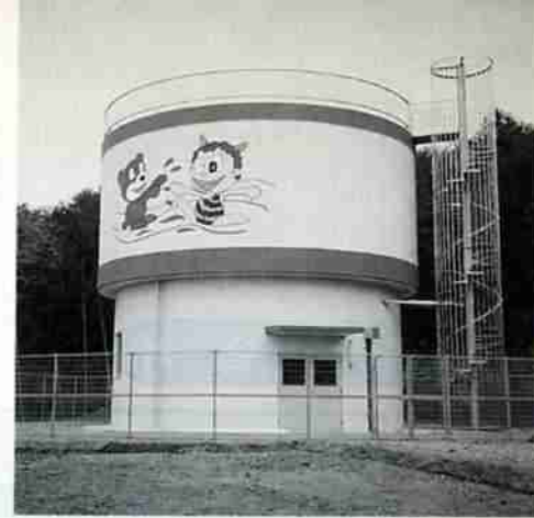
▲水量不足と低水圧解消のため新設された 美園配水池（美園町6丁目）
