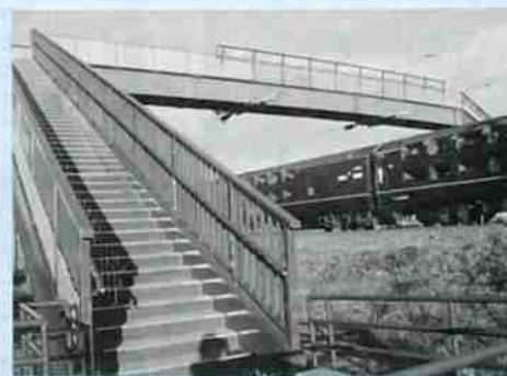
▲ロードヒーティングされた若草こ線人道橋
