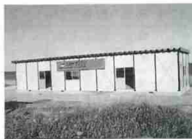
▲清掃工場横リサイクルハウス
