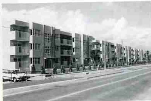
▲完成した道管桜木団地（第1期工事）
