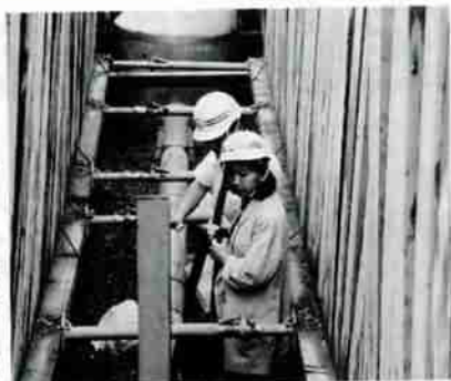
▲桜木町の開削工事現場
