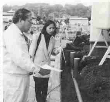
▲排水設備工事中の志村さん宅
