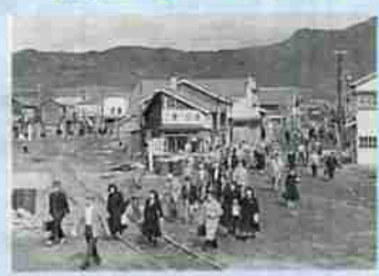
▲幌別駅と幌別鉱山を結ぶ軌道
