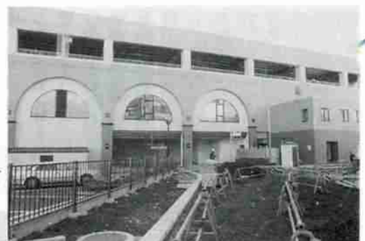
▲アーニス駐車場入口。市道はカラー舗装に整備中。
