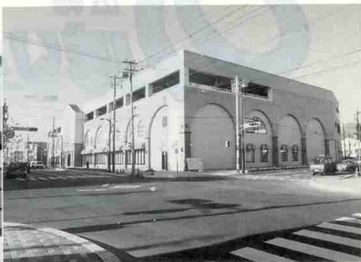
▲▲アーニスは、敷地6,828平方メートル。鉄筋コンクリート造り4階建て。延床面積14,328平方メートル、総事業費用約35億円で建設。
