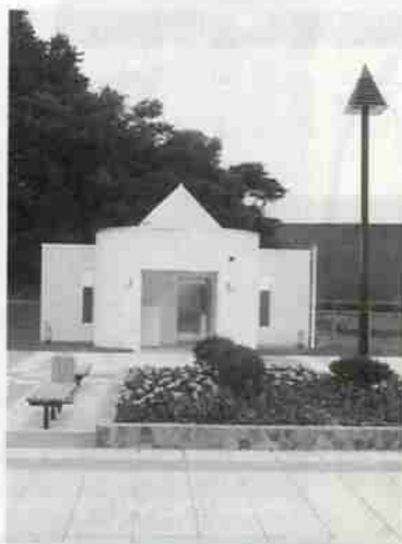
▲モダンな外観のトイレ
