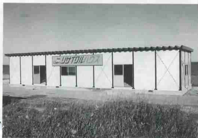
▲市清掃工場横(幸町)に完成した「のぼりべつリサイクルハウス」
