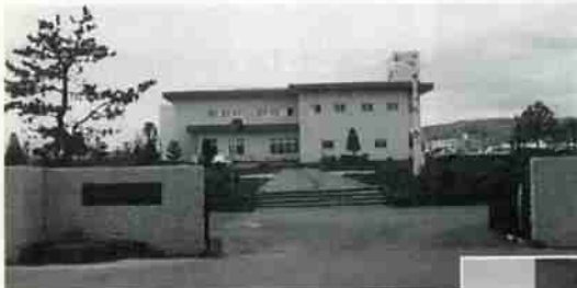
▲若山浄化センター
