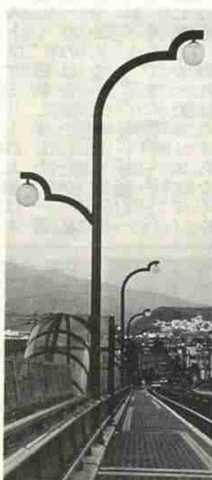
西通立体交差橋 照 明 灯
