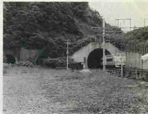
トンネル工事の難所だった伏古別トンネル
