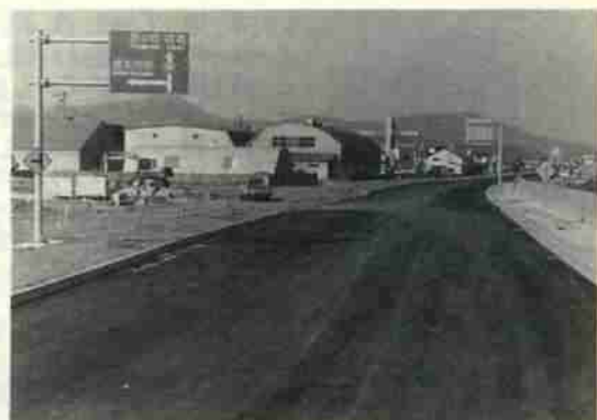
海岸沿いの幌別バイパス
