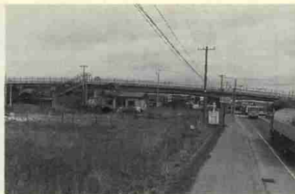
JR路線と国道をまたぐ立体交差橋
