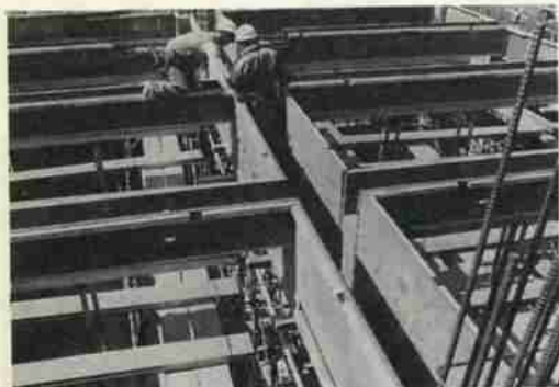
新開発のPCF型枠を使用した工法。この枠の中にコンクリートが流し込まれ、そのまま建物の梁となる。
