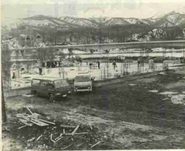
本年秋完成に向けて工事が進む「総合福祉センター」
