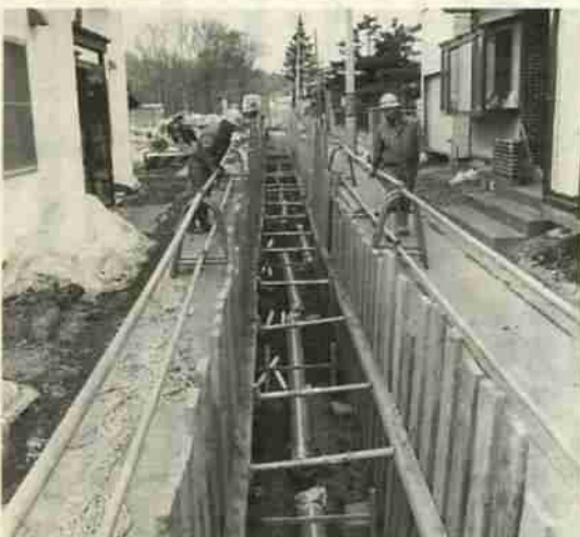
下水道工事が進む常盤町3丁目
