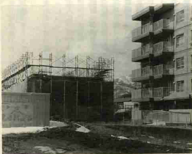
4号棟の建設が進む市営緑ヶ丘団地
