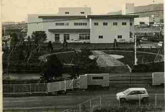
若山浄化センター
