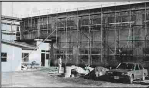
③ 幌別中学校校舎改造事業
