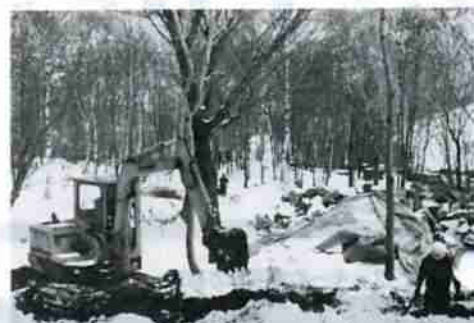
▲雪の中、ナナカマドの広場が作られています。写真右手には地獄谷が一望できる張り出し展望台が設けられます。
