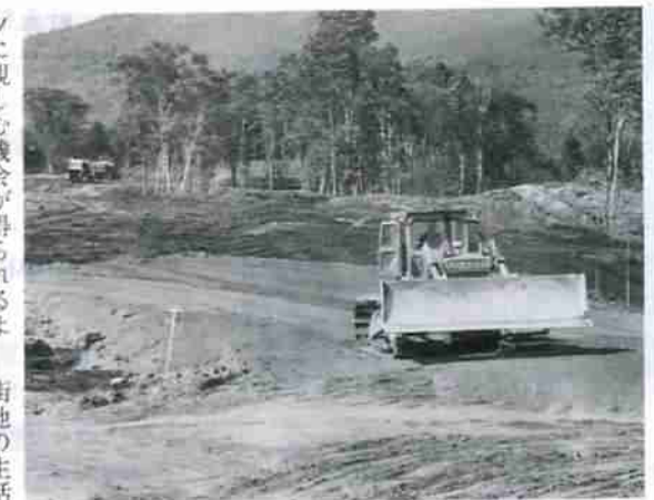
順調に造成工事が進む新ゴルフ場・登別カントリークラブ。 昭和64年5月には、18ホールの本格的ゴルフ場がオープン予定です。
