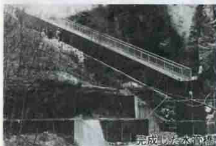
完成した水管橋
