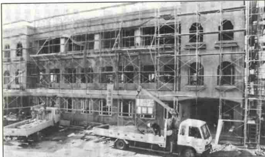
↑ (鉄南ふれあいセンター新築事業) 福祉・ボランティア活動の場として鉄筋コンクリート3階建て延べ1245平方メートルで建設されています。事業費2億5千万円。
