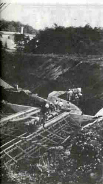
←〈登別市中登別老人ホームの沢渡旧治山事業〉昨年の大雨災害の復旧工事として工事費四千二百四十三万円、延長百二十五・五mの水路上の新設や橋脚などの工事が行われ、完了は十一月末までとなっています。
