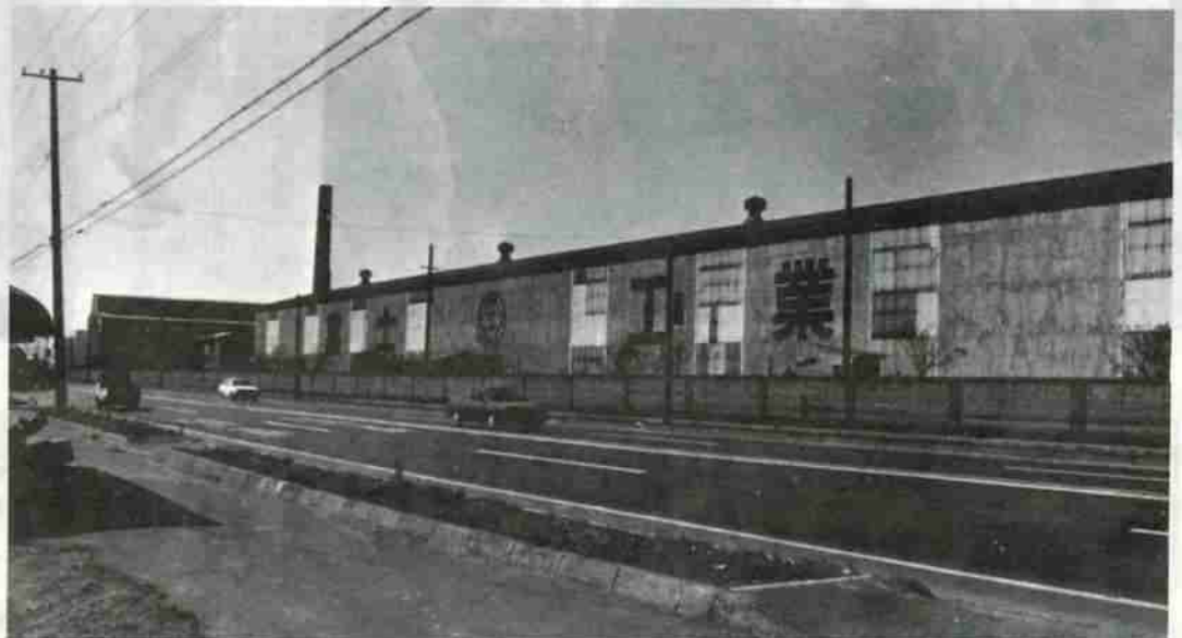
閉鎖されることになった富士工業株式会社室蘭工場
