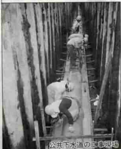
公共下水道の工事現場
