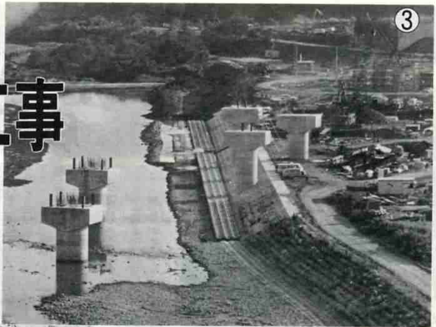
幌別ダム下架橋工事
