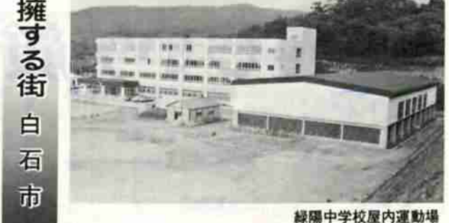
緑陽中学校屋内運動場
