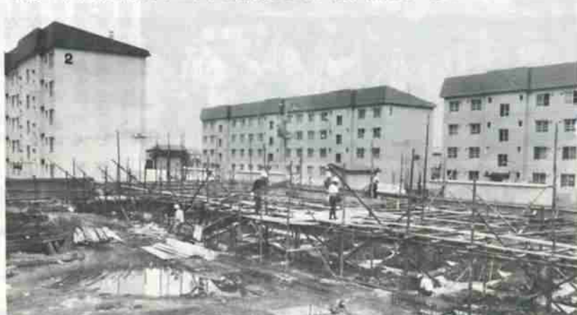
《公営住宅建設工事(新生団地)》 新生町2丁目に5階建て1棟30戸(3LDK)の工事がスタートしました。今年度は、登別温泉町にも、2階建て4棟16戸(3LDK)が建設されます。
