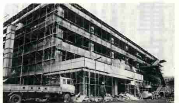
登別中分教場(仮称)建設工事
