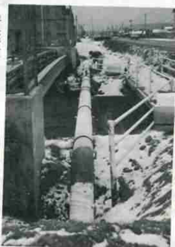
着々と進む配水管布設事業(第一期拡張事業、幌別町8丁目付近)
