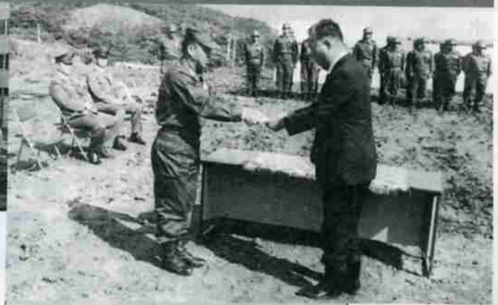
鷺別中学校分教場敷地造成
