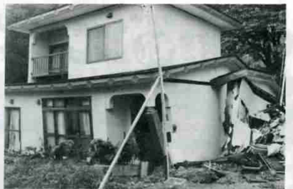
ガケ崩れのため新築家屋も破壊されました（片倉町）
