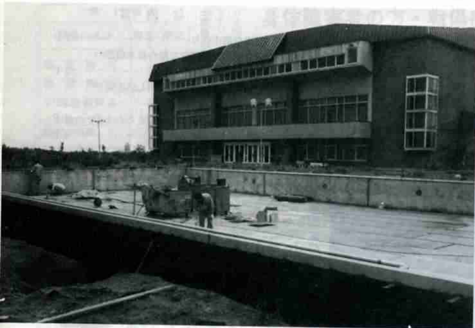
登別市民水泳プール新設工事
