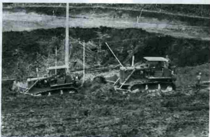
新設中学校の敷地造成工事（富岸町1丁目）
