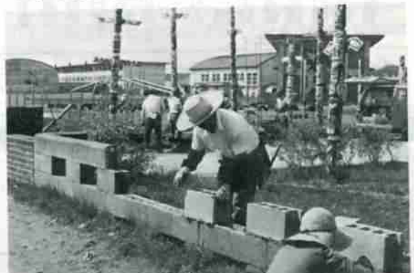
鶴別小学校のブロックべい補修工事
