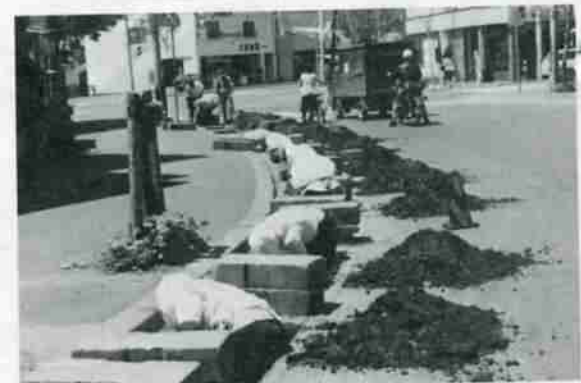
側溝の泥土除去作業（富士町）
