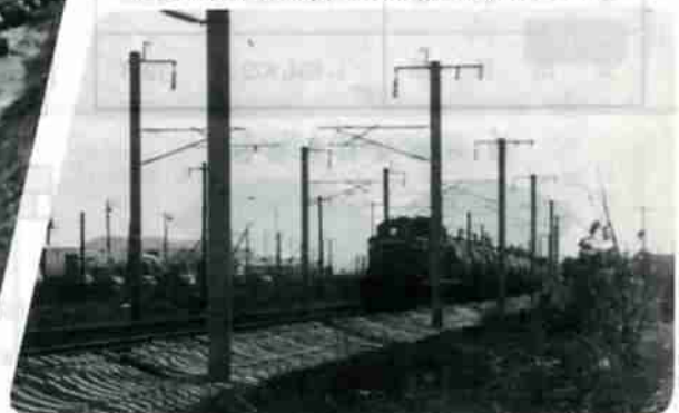
架線も張り終わり電車が走るのをまつだけのところもあります。(若山町…札幌踏切り附近)
