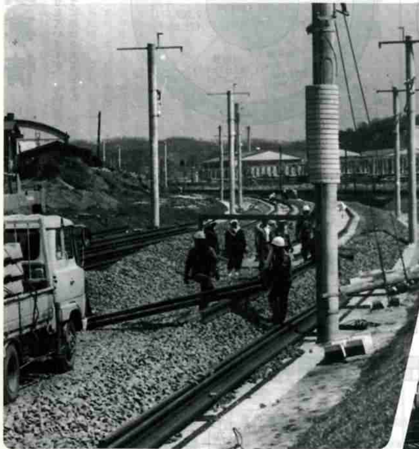
電化工事は架線工事ではありません。架線工事にあわせて、線路の切り換え工事も同時に行なわれています。(登別港町蘭法華トンネル付近)
