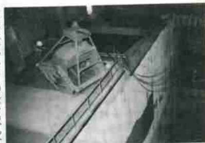
ゴミはクレーンで燃焼室へ
