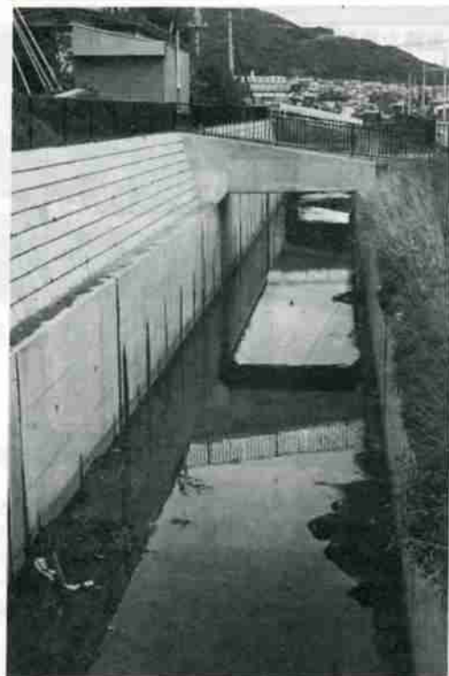
改修工事が進む上登別富岸川の完成部分
