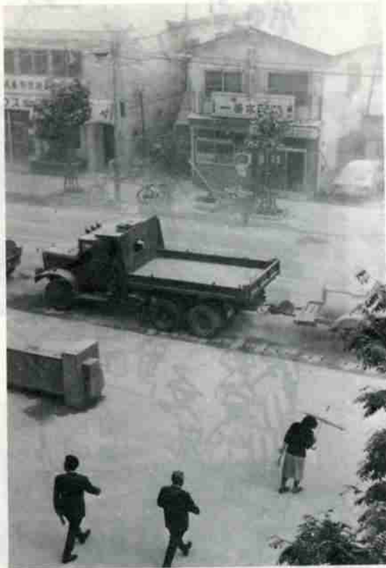
市内全域に降った灰は、いろいろな形の被害をもたらした。各家庭では窓も開くことも出来ない日が続く。道路上のわずかな灰は車の通行で舞い上がって人々を困らせ、農家の人たちは家畜飼料の確保で頭を痛めた。
