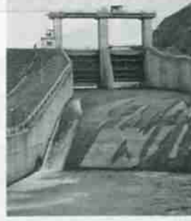
ゲートを上げ放流中の幌別ダム
