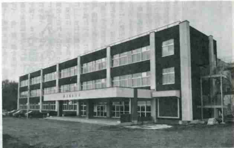
よりよい教育環境をめざし、危険校舎等の新設、増改築さらに備品教具、教材の充実を図っています。写真は4月に開校した青葉小学校。
