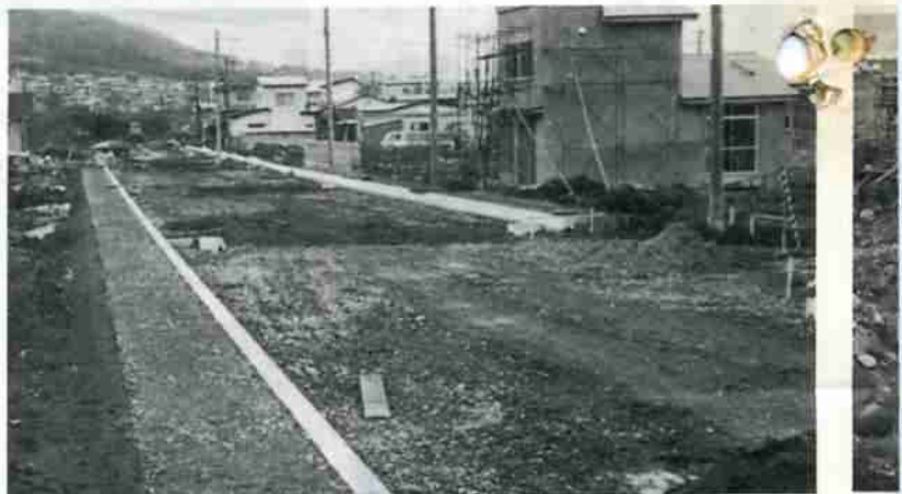
学田通り（若草町）の道路改良事業はいまさかに行われています。
