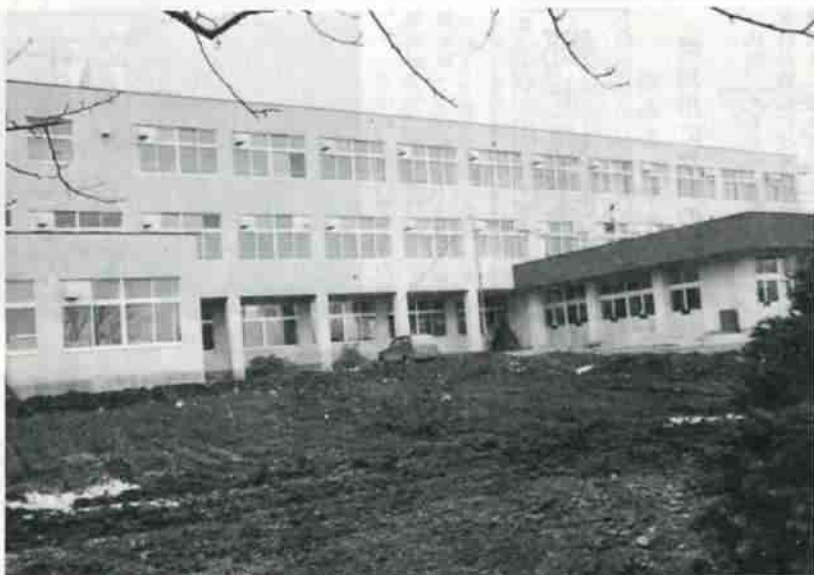
充実した教育環境整備に力を入れ各校の増改築等が急ピッチ（幌別中学校増改築）
