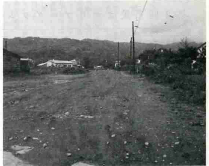
舗装工事により一新されることになった片倉通り
