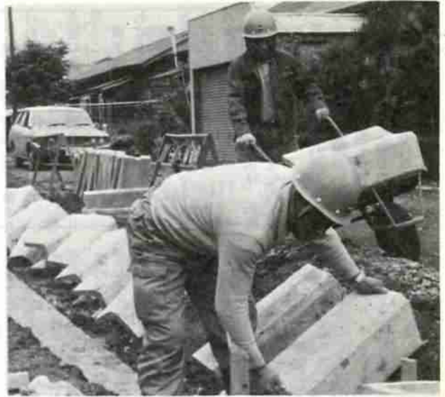
富士路線の道路舗装工事もよう
