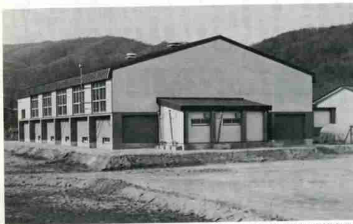
富岸小学校屋内体操場新築事業
