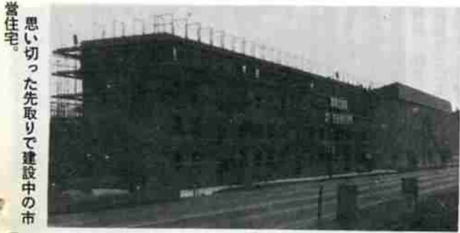
思い切った先取りで建設中の市営住宅。
